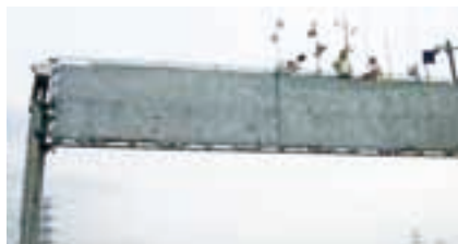
检查龙门架设备
