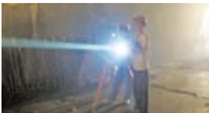
洞内照灯测量
